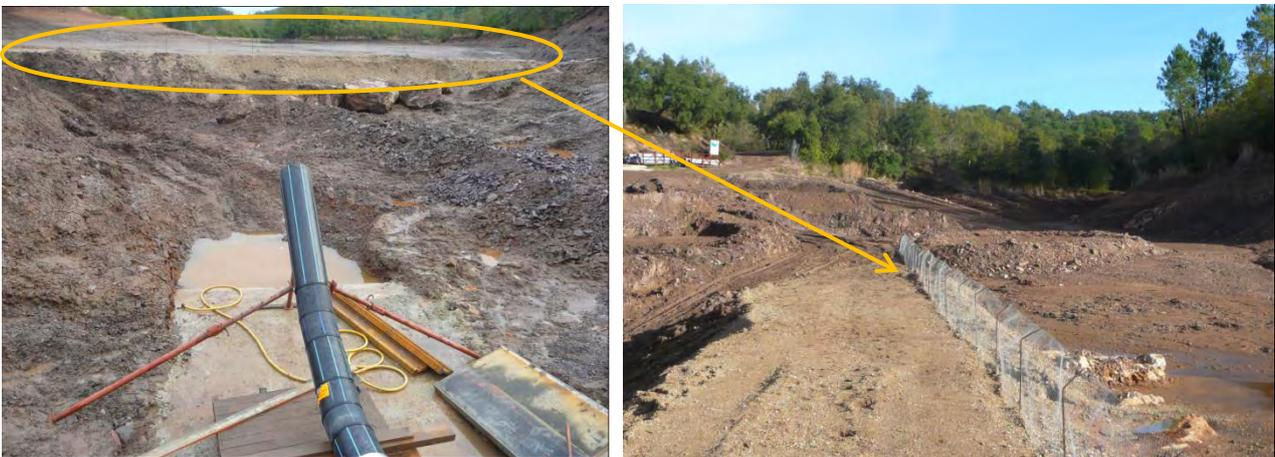
**Figure 34. EXEMPLE DE CLOTURE D'EXCLUSION MISE EN ŒUVRE POUR LA VIDANGE ET DU CURAGE DU BARRAGE DU RIOUTARD (SIACSE, 2013)**
