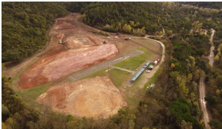
Terrassement du dépôt du Lenté
