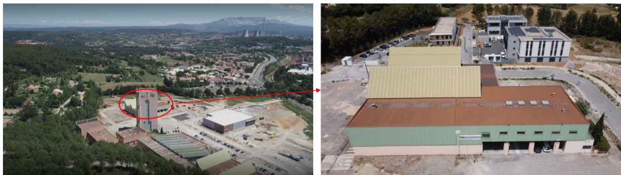
Illustration 2 : Bâtiment de l'UTAM Sud - Gardanne (13).
