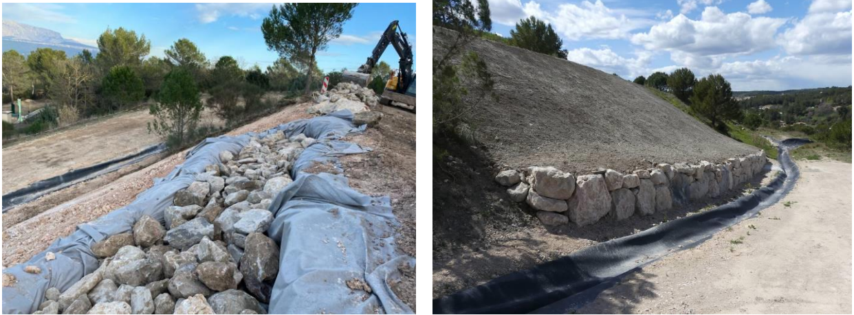
Illustration 18 : Travaux de drainage (gauche) et déstagement (droite) réalisés sur la banquette n° 4 et sur le talus du teril du Grapon – Commune de Meyreuil (13).
