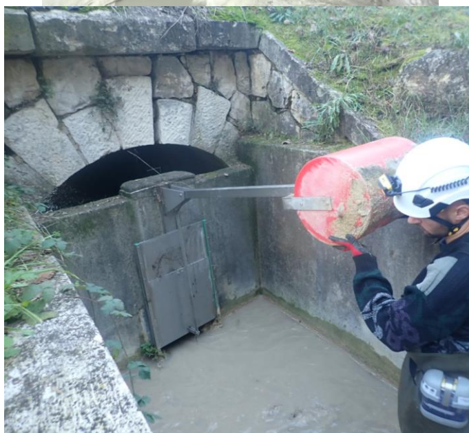
Illustration 10 : Visite de la galerie d'Audibert vue depuis l'aval (gauche) et contrôle du fonctionnement de l'ouvrage sous l'ancienne voie ferrée (droite) – terril de Mme d'André - Fuveau (13) (19/12/2023).
