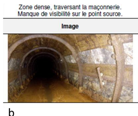
Illustration 37 : a : Vue en coupe de la galerie ; b : État des parements et radier, photo prise à 50 m de l'entrée de galerie – Manosque (04).
