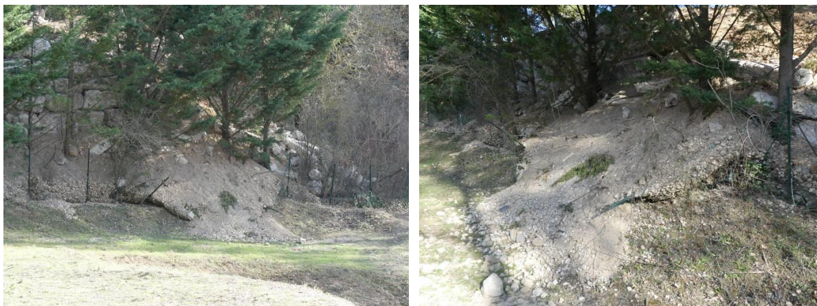
Illustration 14 : Débordement de terres depuis la parcelle voisine et clôture détériorée – terril des Sauvaires (Gardanne – 13).
