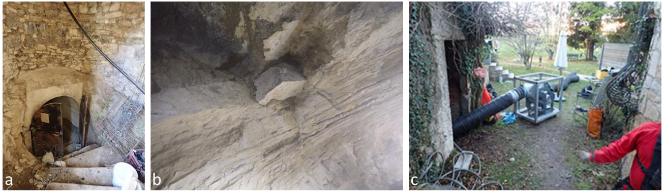
Illustration 32 : a : Entrée de la descenderie, b : décrochement de bloc au toit et dans le parement, c : système de ventilation mis en place pour éliminer le risque d'asphyxie – Ventabren (13).
