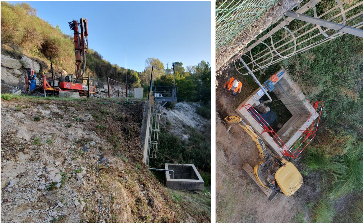
Illustration 21 : Investigations géotechniques autour du mur de soutènement du terril des Sauvaires : sondage pressiométrique en amont du mur (gauche) et puits de reconnaissance en pied de mur à l'aval (droite) – Gardanne (13).
