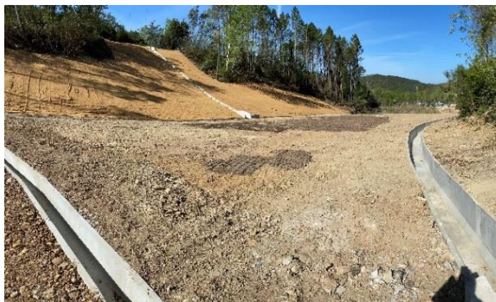
Confortement de zones d'érosion
