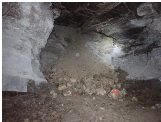
Illustration 29 : Pilier en bon état (photo de gauche), secteur effondré avec écoulement argileux (photo de droite) - Marseille (13).
