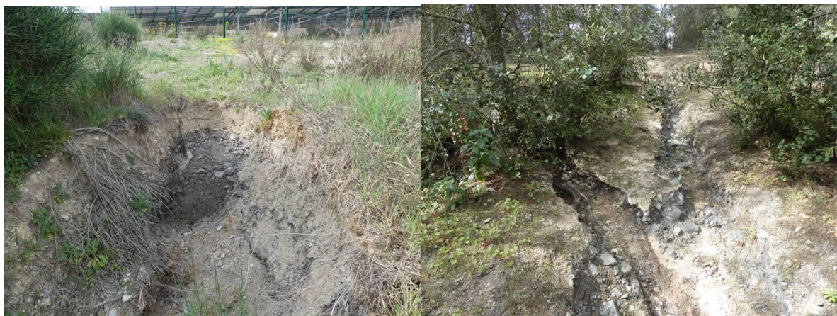
Illustration 16 : Tête de ravine à l'est de la centrale solaire et poursuite de l'érosion dans le couvert végétal en contrebas sur le terail du Défens – Commune de Meyreuil (13) – 14/03/2023.
