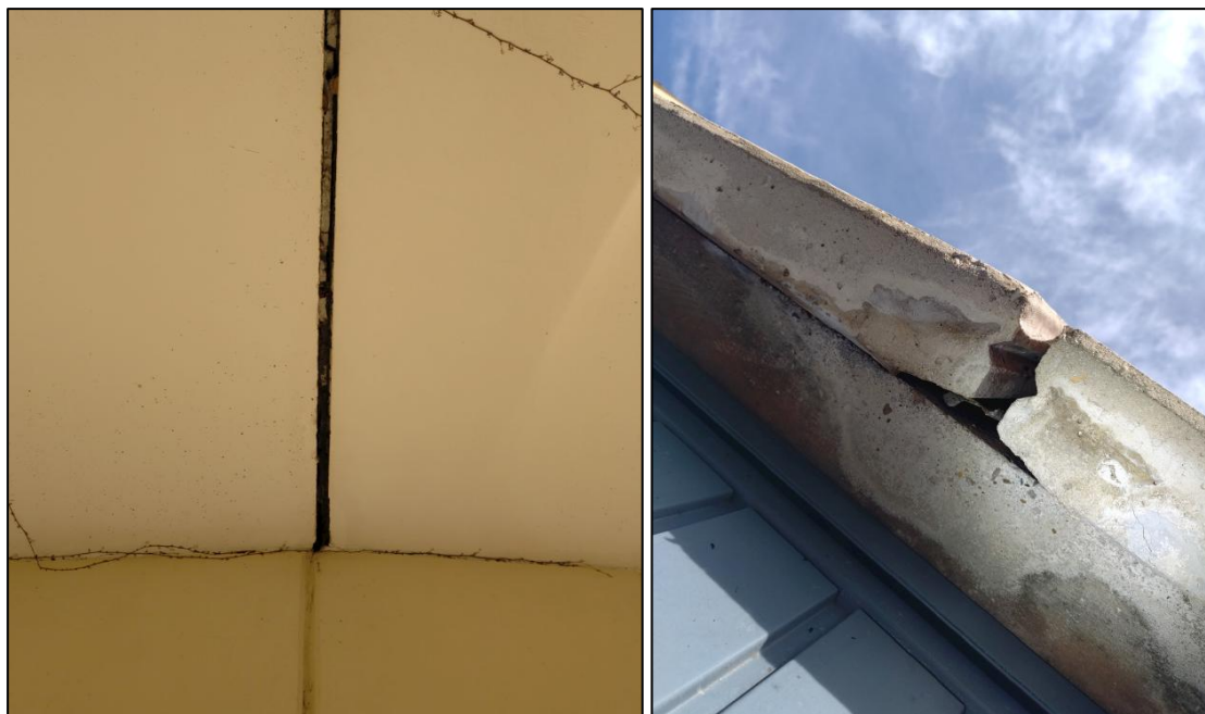
Figure 6 : Type de fissures profondes (jointures bloc béton, bords de toiture) existantes
