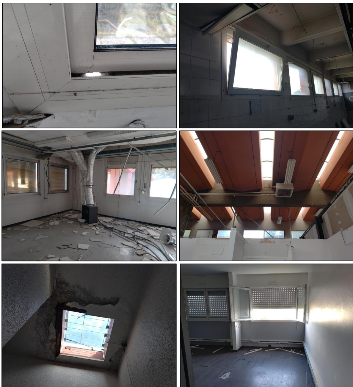
Figure 11 : Ouvertures et fissures présentes dans tous les bâtiments
