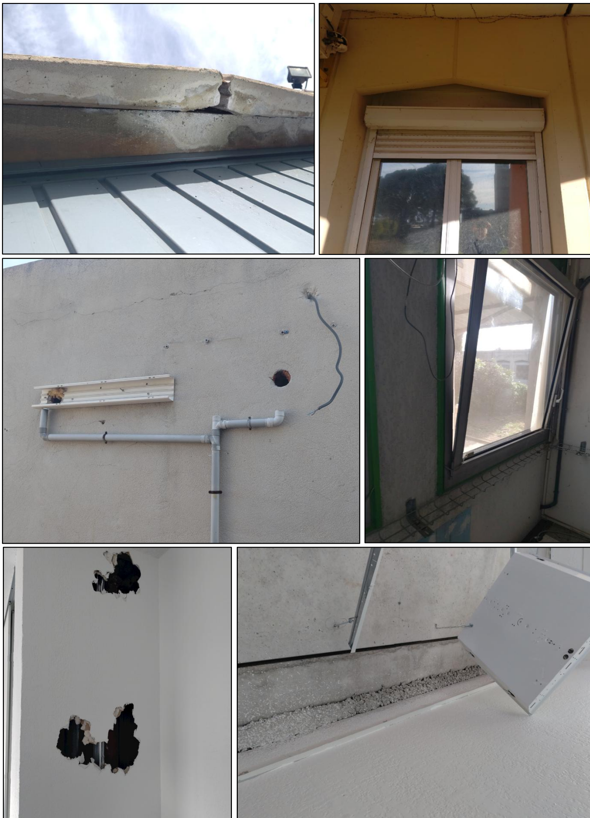
Figure 7 : Anfractuosités, ouvertures et fissures observées sur les différents bâtiments
