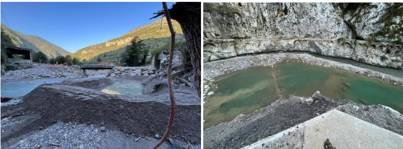
*Figure 4-Principe de chenal de filtration, chantiers de la Roya*
