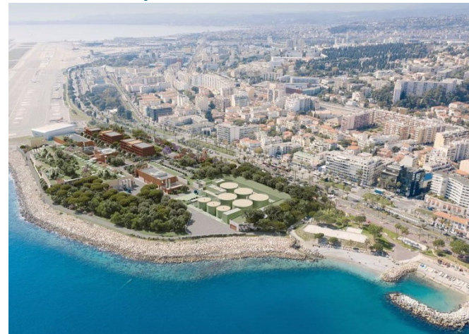
Station d'épuration Haliotis 2 à Nice
