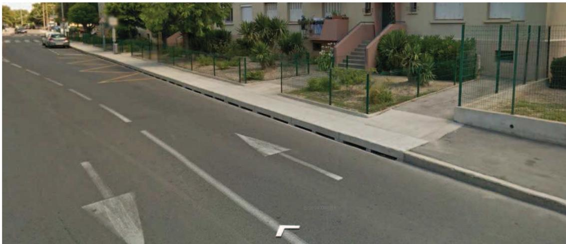
Figure 16 : dispositif d'engouffrement latéral intégré au trottoir
