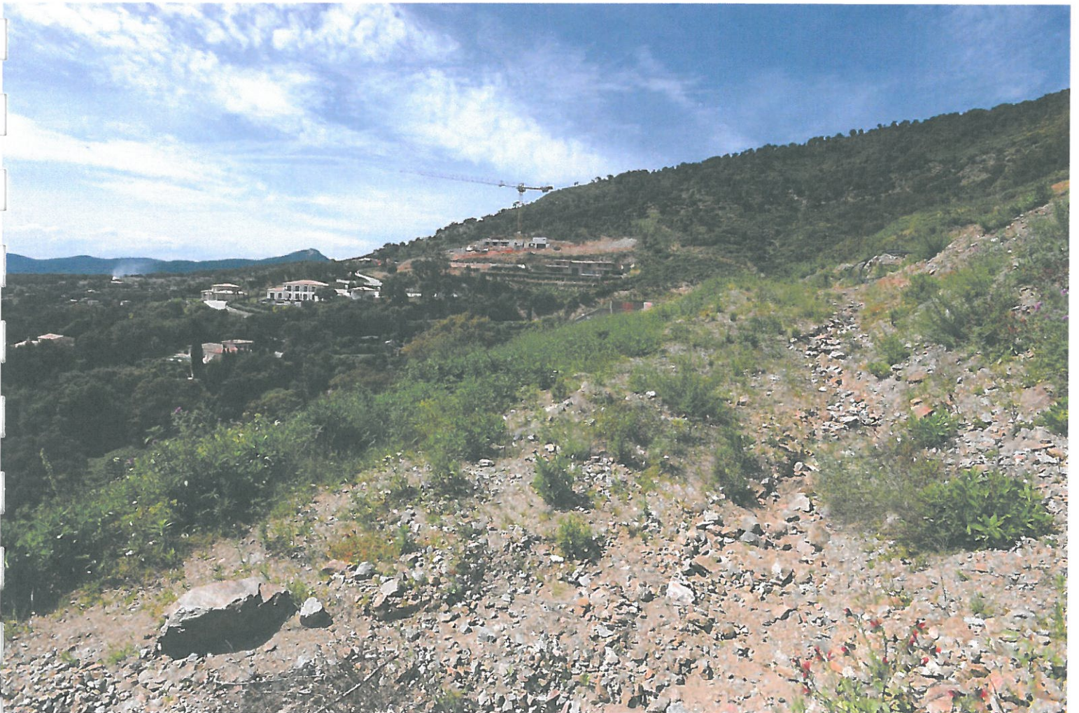
Photo n°6 - Date de prise de vue : 29/04/2015
