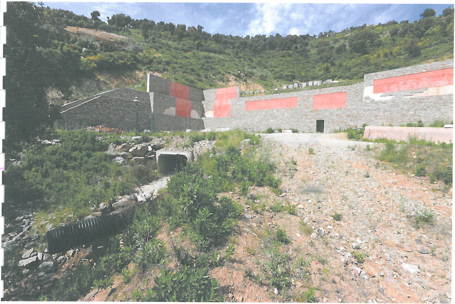
Photo n°9 - Date de prise de vue : 29/04/2015
