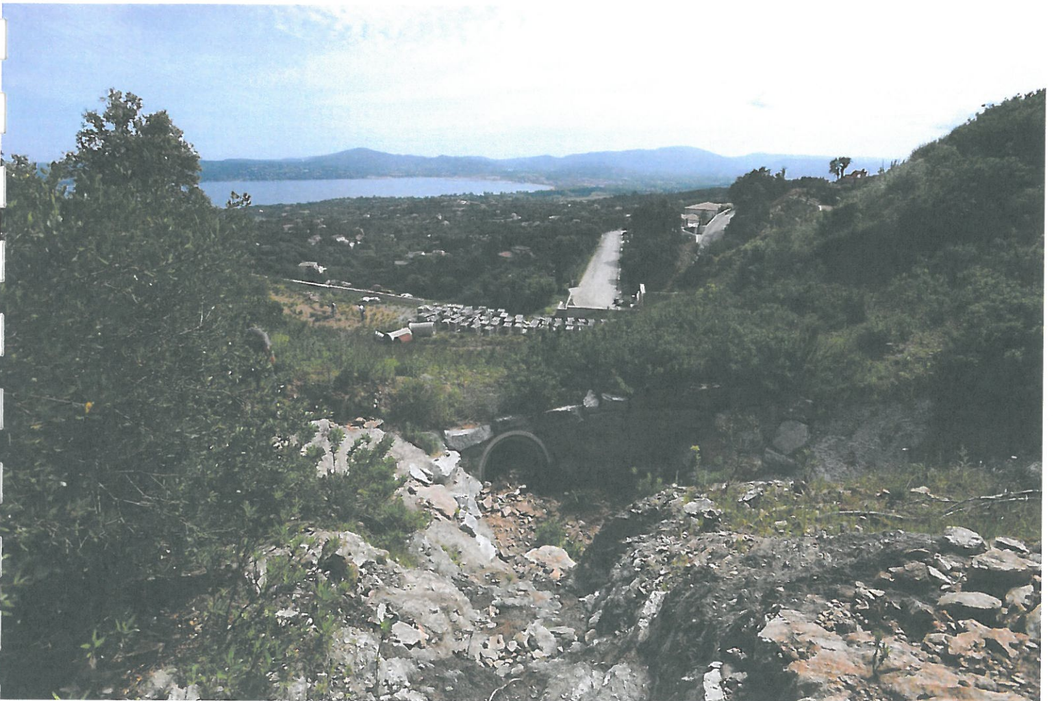
Photo n°10 - Date de prise de vue : 29/04/2015
