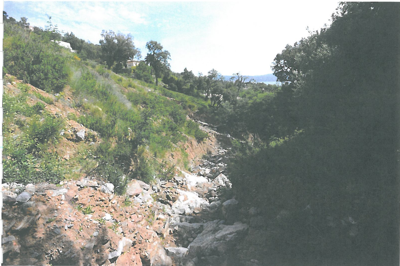
Photo n°16 - Date de prise de vue : 29/04/2015
