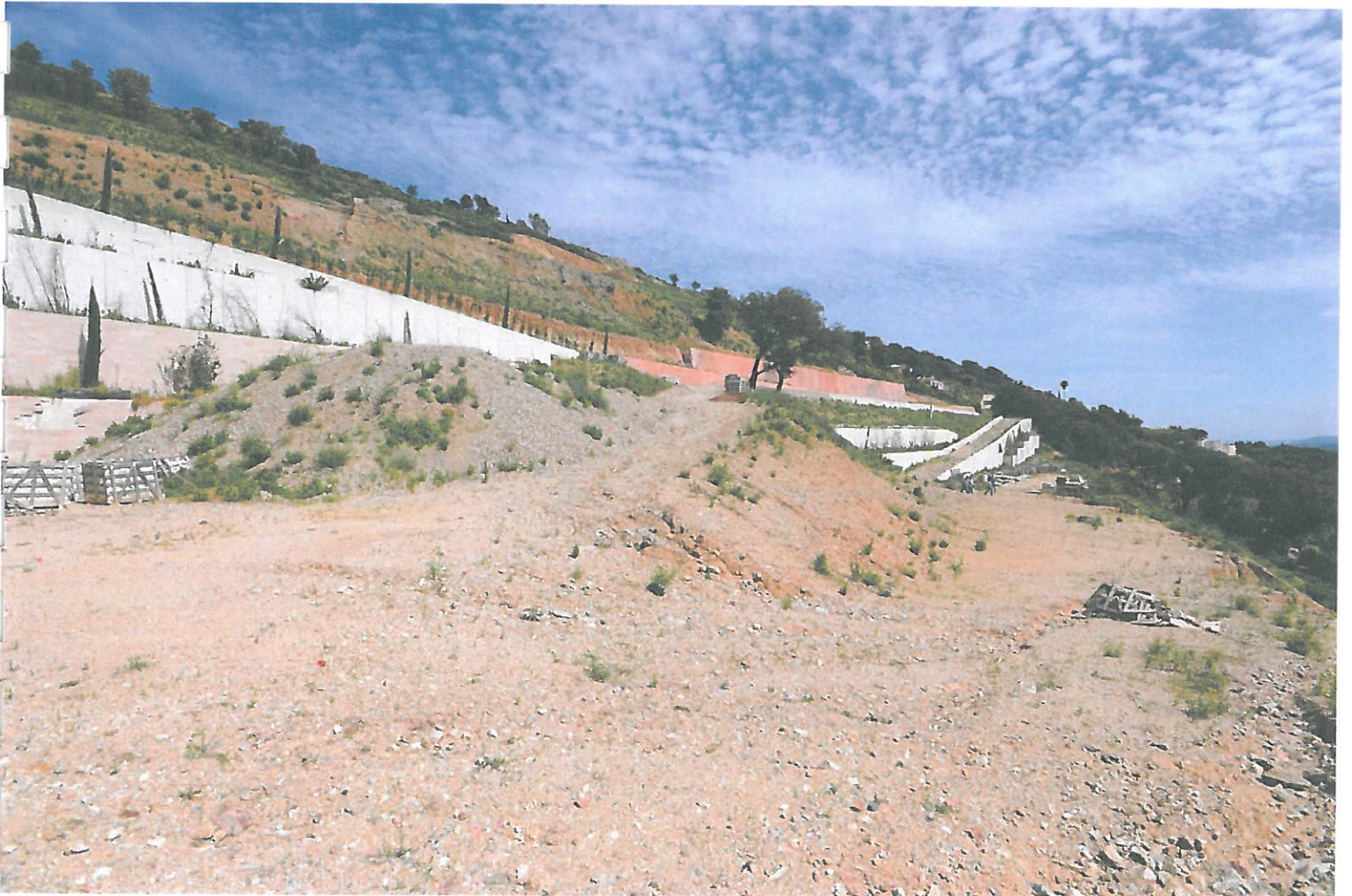
Photo n°8 - Date de prise de vue : 29/04/2015
