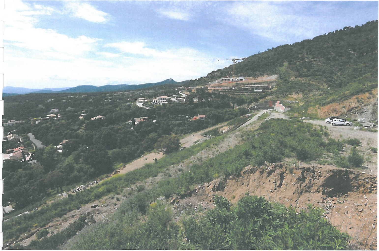
Photo n°3 - Date de prise de vue : 29/04/2015
