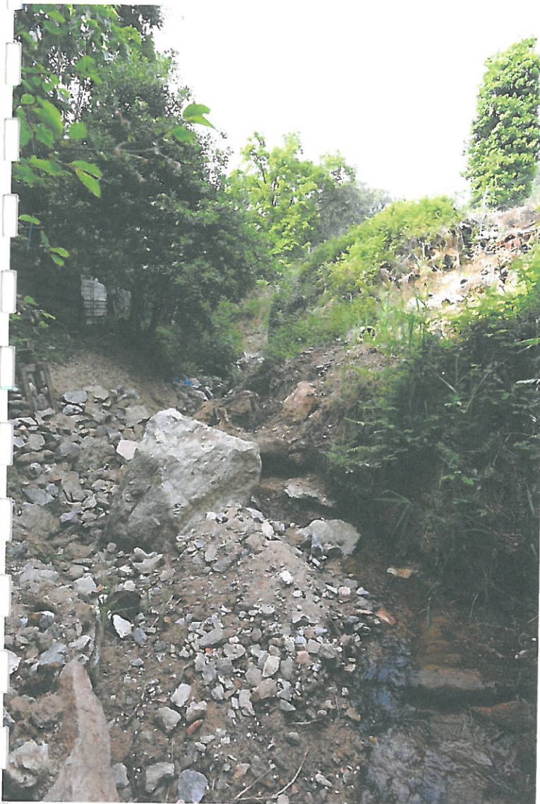
Photo n°20 - Date de prise de vue : 29/04/2015
