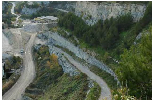
Pieds de front et gradins remodelés et plantés [La Grave-de-Peille (06) - Exploitant : Société Vicat - Nov. 2005]
