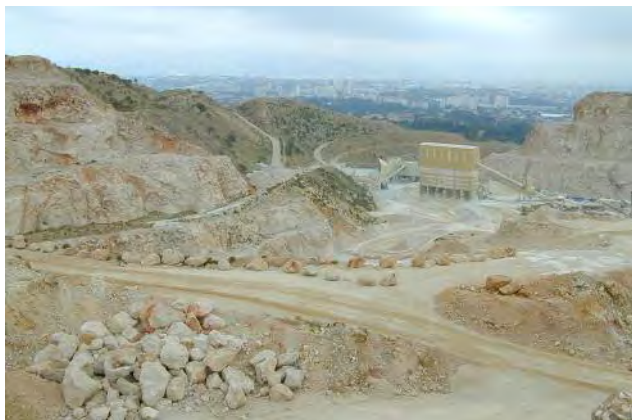
L'excavation de la carrière Sainte-Marthe [Marseille (13) - Exploitant : CBBP - Juillet 2005]
