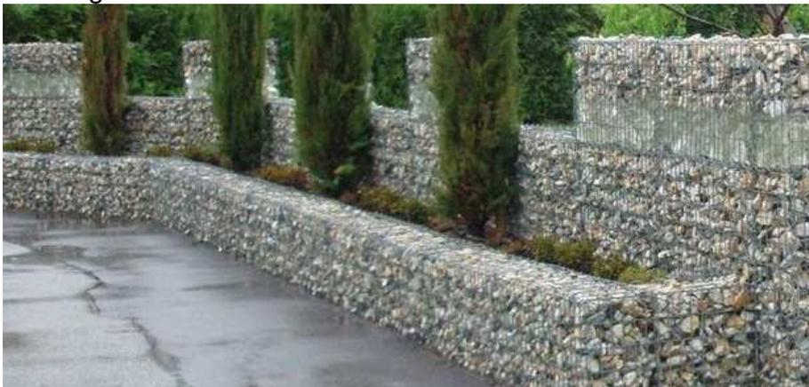
Exemple de traitement des restanques avec des murs en gabion
