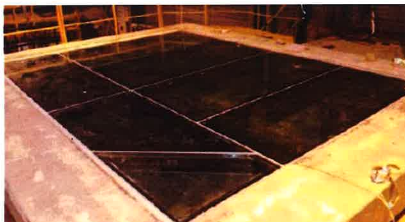
Figure 13 : Plancher de type « verrière horizontale »
