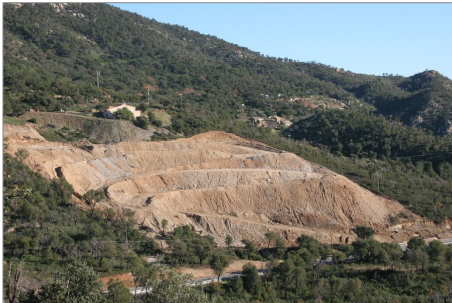
Aménagement situé au sein d'un habitat à Tortue d'Hermann / Photo : J. CELSE
