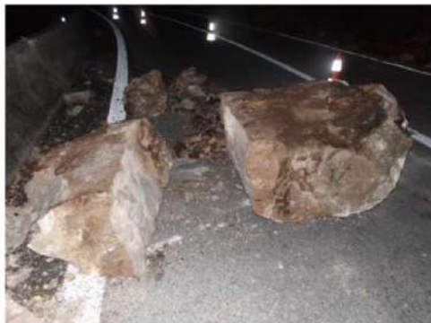
Vue générale du volume rocheux éboulé sur la chaussée - Eboulement du 30/11/2009 – Volume estimé à 2 m³ environ – Extrait du rapport du BET GEOLITHE
