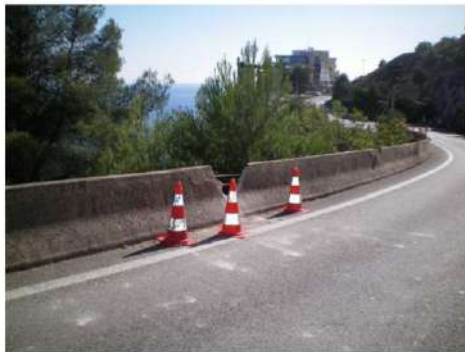
Vue générale de la zone d'impact de la chaussée - Eboulement du 18/10/2009 – Volume estimé à 0,3 m³ environ – Extrait du rapport du BET GEOLITHE
