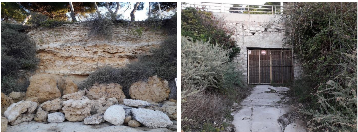
Figure 19. Paroi défavorable aux chiroptères et tunnel de transit des embarcations potentiellement favorable aux chiroptères (Photos sur site : Naturalia)
