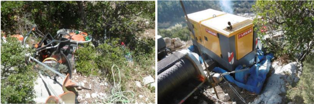
Poubelle pour stockage des bidons de carburant pour tronçonneuse à gauche et stockage des bidons de carburant/d'huile dans bac de rétention à droite (Photos : Naturalia)
