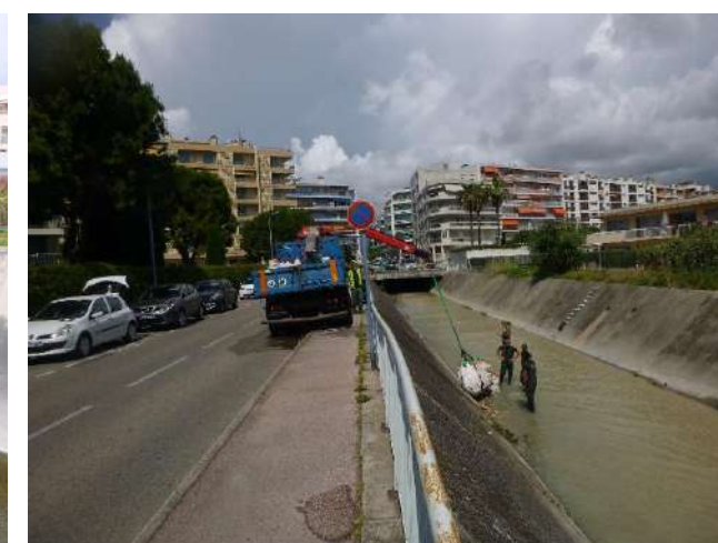
Opération de curage des sédiments contenant de la Jussie à grandes fleurs - ©P. AUDA
