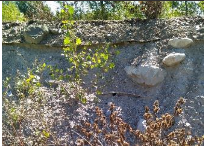
Amorce de trou au niveau de la géomembrane du merlon de compensation
