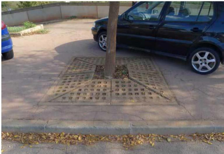
détail: grille d'arbre en béton
