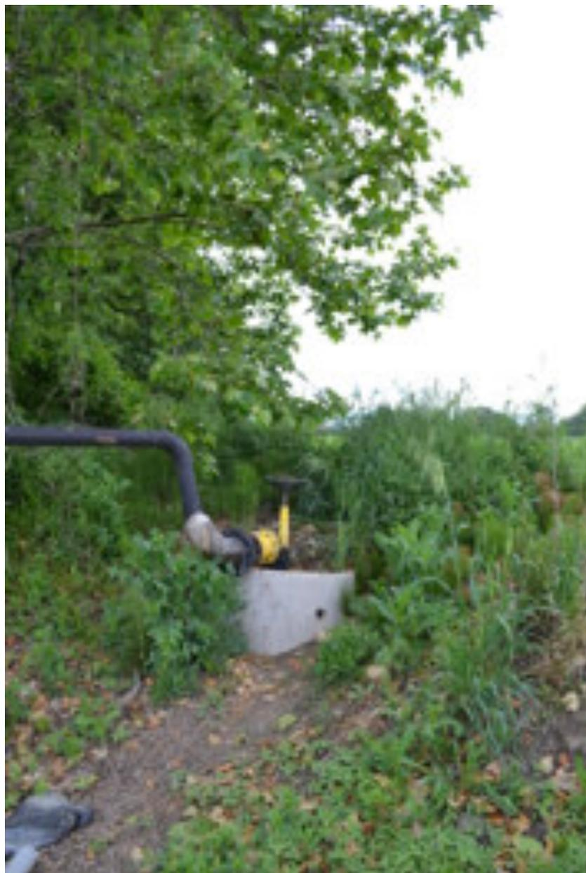
**Figure 9** - Borne d'irrigation (eau sous pression) pour l'irrigation en goutte-à-goutte sous les serres tunnel plastiques
