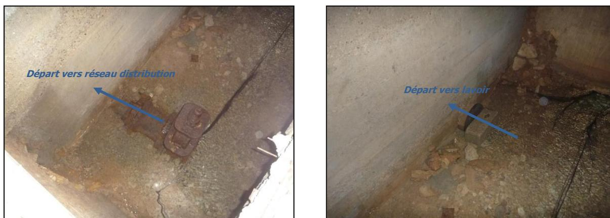
Figure 4 : Photographies des départs d'eau dans la chambre de captage
