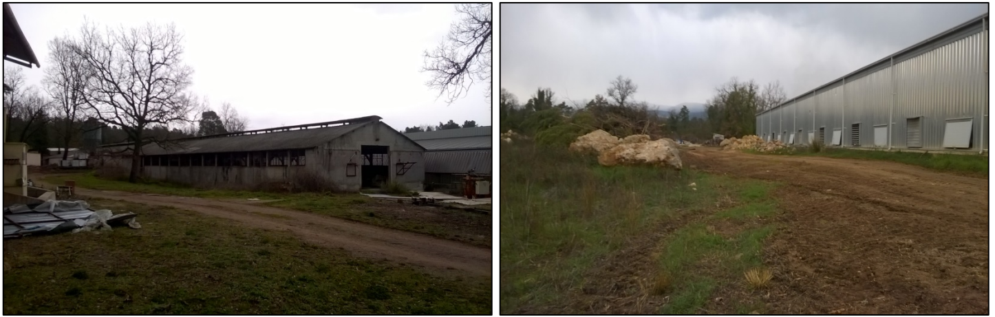
Photo 2 : Hangars avicoles présents dans le secteur d'étude et son environnement dégradé (Géomètre)
