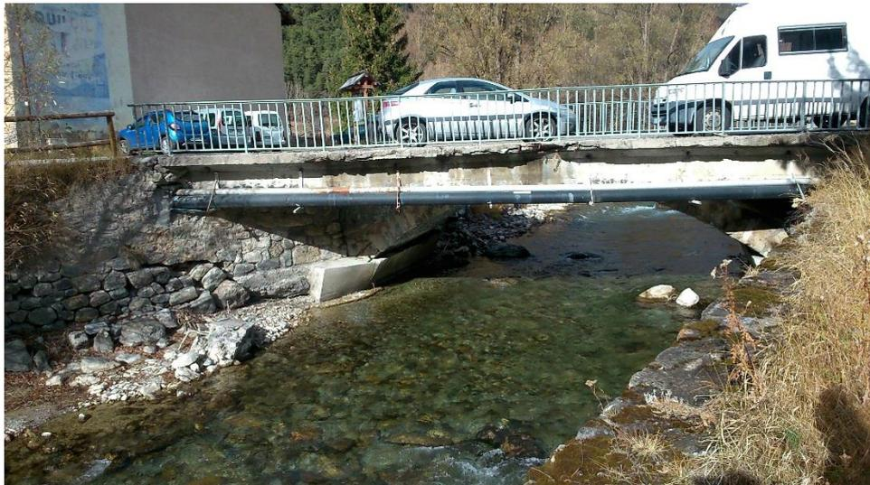
La traversée se fera en encorbellement sur le côté aval du pont
