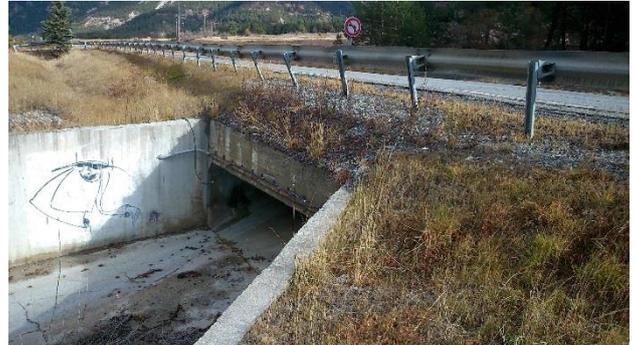
La traversée se fera en surprofondeur au niveau des enrochements.
