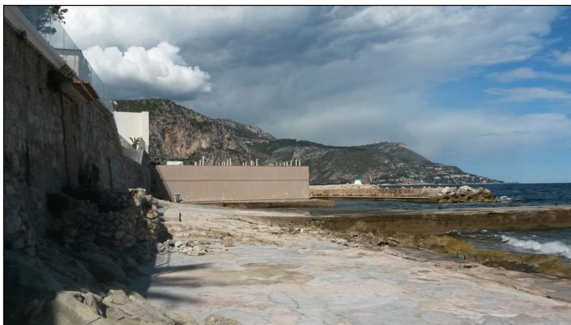
Photographie 2 : Domaine public maritime en limite de la propriété de la SAS METROPOLE – Vue vers le Nord
