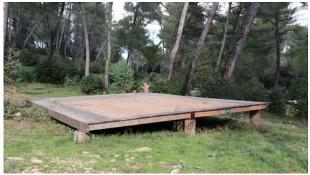
*Exemple de plancher bois mis à niveau sur rondin permettant l'installation de tente sans terrassements*
