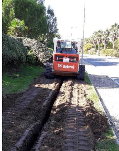
Les photographies ci-dessus présentent une trancheuse qui est similaire à celle qui va être utilisée pour le projet. Sa largeur est faible environ 2 mètres, et peut réaliser une tranchée de 40 cm et de 1 mètre de profondeur.
