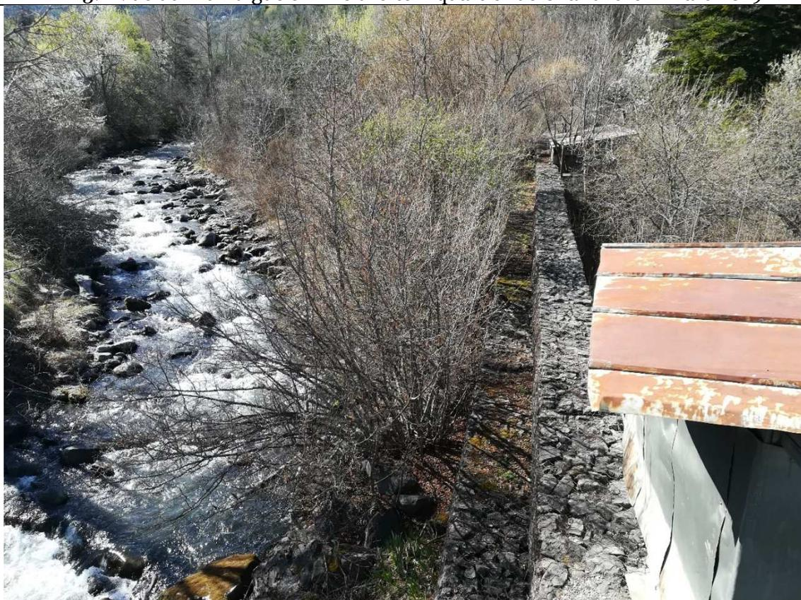
4. Vue de la digue en gabions rive gauche en amont du pont – mars 2019
