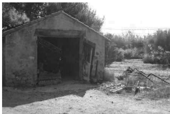
Cabanon au sud-est du site.
