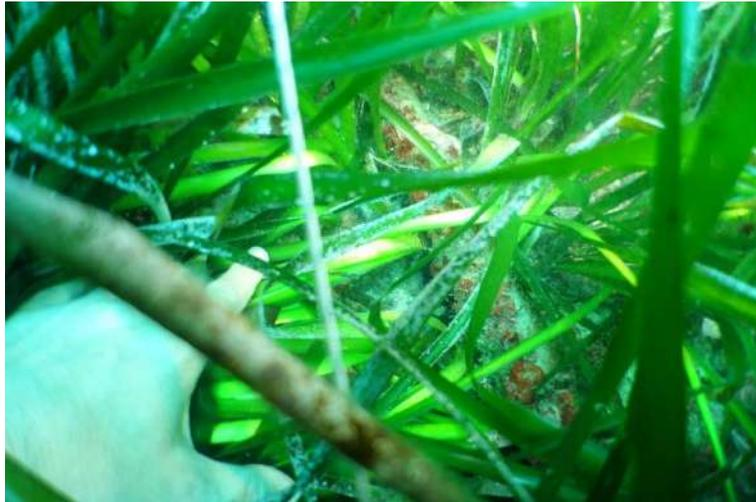
*Figure 85 : Câble télécom au sein d'un herbier entre les faisceaux de posidonie (Marseille, 2020)*
