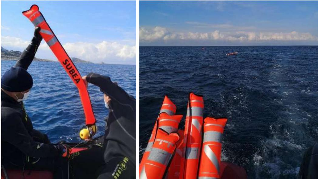
*Figure 7 : Installation des balises le long du tracé des câbles*
