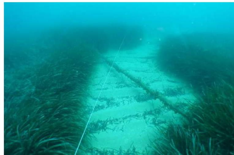
*Figure 84 : Câble télécom en suspension au passage d'une zone d'intermatte (Marseille, 2020)*
