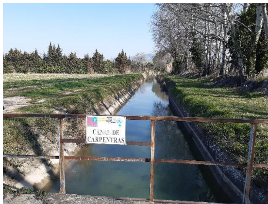
Figure 13- canal de Carpentras. Le terrain est à gauche du canal
