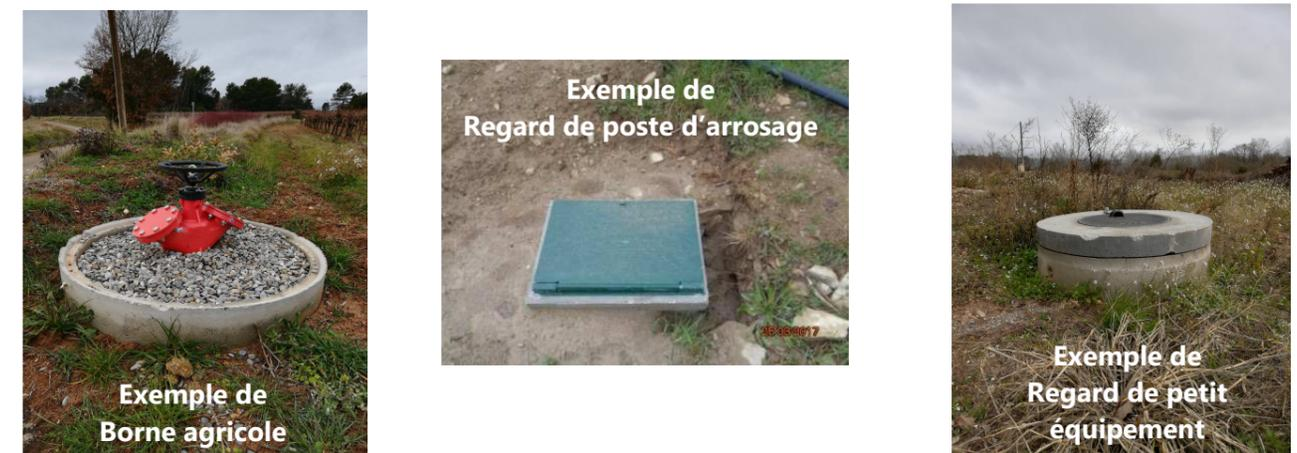
Figure 9 Exemples d'équipements annexés au réseau de canalisations enterrées
