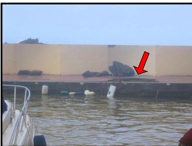
Photos 3 et 4— Une borne arrachée par une vague et l'impact des rochers sur le bitume- mai 2010
