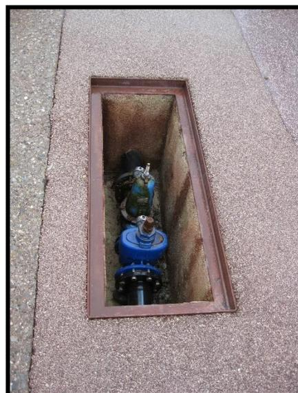
Photo 10 : Détendeur endommagé
