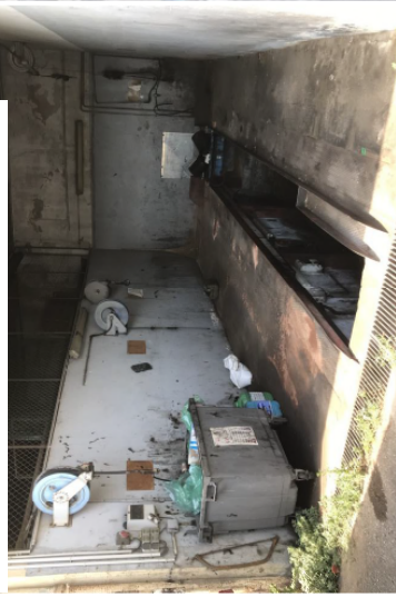
Photo 2 : Pont de réparation et d'entretien
