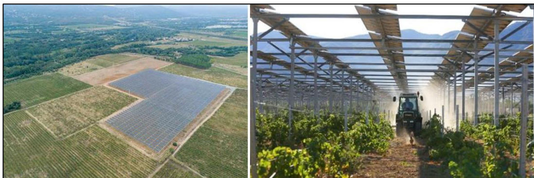
Démonstrateur agrivoltaïque de Tresserre (66) – Domaine de Nidolères
