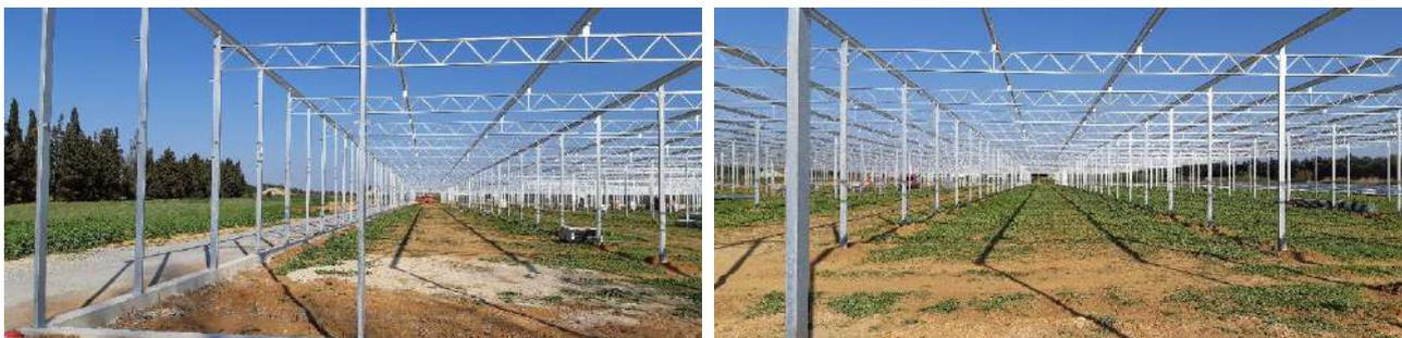
**Figure 11** : Montage structure d'une serre photovoltaïque. Source : Reden Solar.
