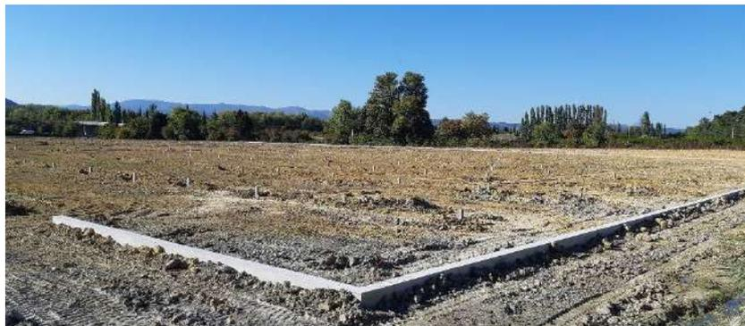
**Figure 13** : Fondations béton extérieures (longrine). Source : Reden Solar.
