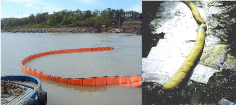
Figure 25. Installation d'un barrage flottant / barrage absorbant ((<http://www.flexitankchina.fr>) / ([cedre.fr](http://cedre.fr)))
