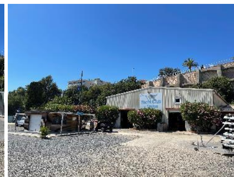
4. Le bâtiment principal du Yacht Club de Toulon
