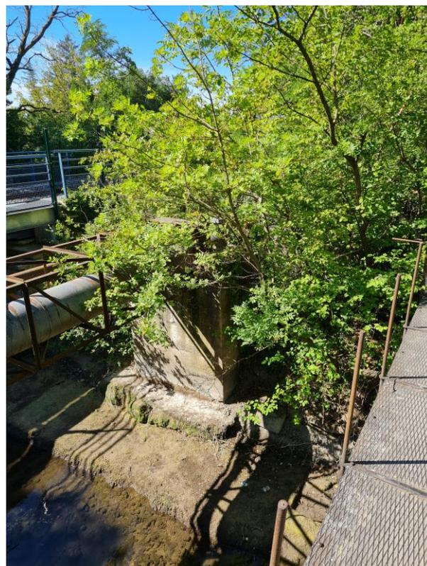
Lors des travaux, il est envisagé d'enlever les broussailles, ronces autour des plots en béton pour permettre l'accès aux ouvrages aux équipes travaux. La surface ainsi débroussaillée est estimée à 300m<sup>2</sup>, elle sera remise en état après avec des espèces endémiques du lieu.
