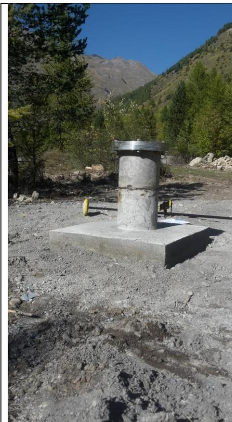
Figure 1 : forage F1 à équiper d'une pompe
