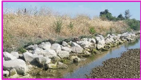
Une analyse rapide de la morphologie du site, de l'historique spatial de la construction des enrochements et de l'érosion progressive de la berge vers l'aval, montrent que les aménagements mis en œuvre jusqu'à présent ne permettent pas de garantir la sécurité du pipeline.
