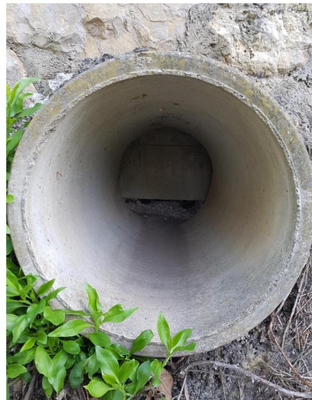
Photographie 6 : Ø 500 mm béton issu du cimetière des Roumiguières et dirigé vers le terrain du projet
