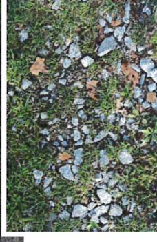
Exemple de stationnement sur mélange terre- pierre enherbé
