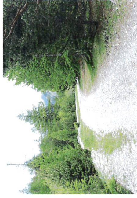
Grave compactée pour voie de parking et chemin
