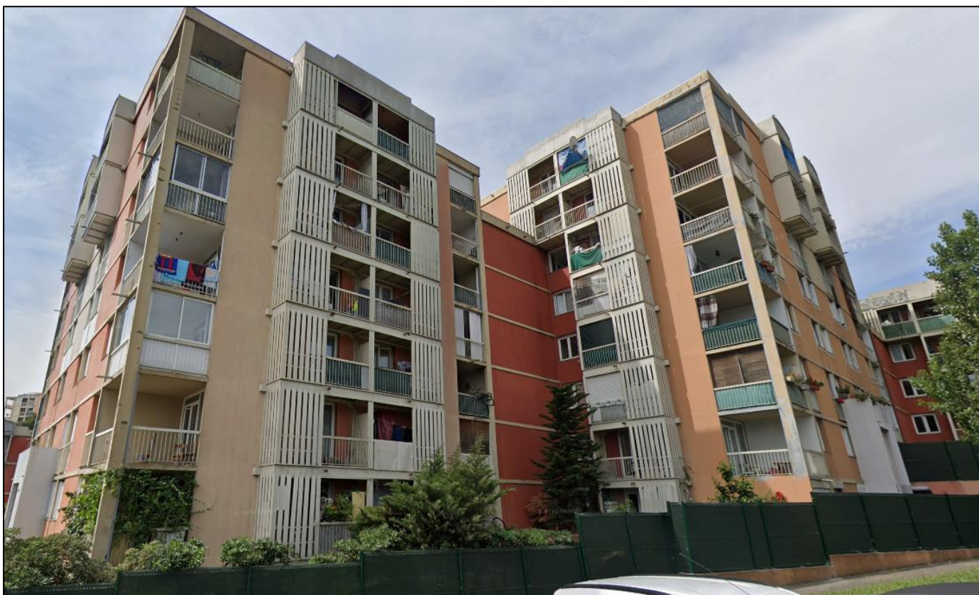
Photo 5 : Autre exemple bâtiment (nord).
