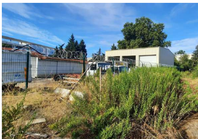
Photographie 3 : Bordure sud du site d'étude
