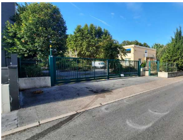
Photographie 5 : accès au site d'étude
