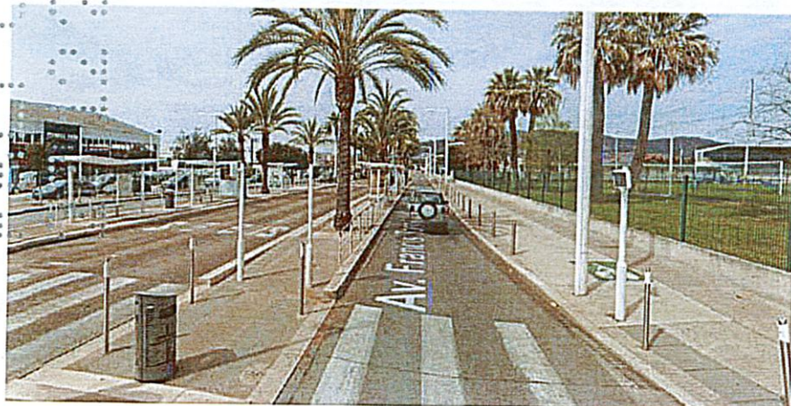
Aménagements de la voirie avenue F. Tonner
