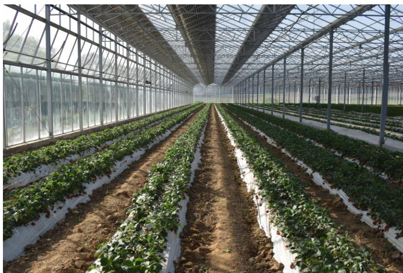
Figure 19 - Fraises sous serre photovoltaïque. Reden.
