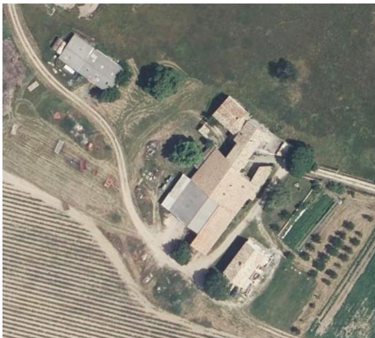
Figure 6 - Bâtiments de l'exploitation sur le site principal à Revest-du-Bion. Image satellite, Géoportail.
