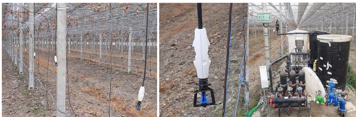
Figure 21 - Exemple de système d'irrigation par aspersion et goutte-à-goutte de cultures de kiwis rouges sous serre agrivoltaïque. Reden.
