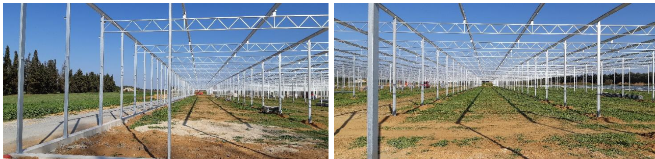
Figure 25 - Montage structure d'une serre photovoltaïque. Reden.
