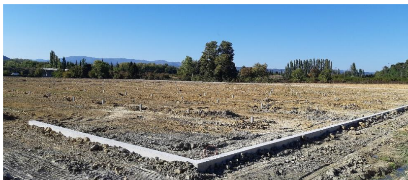
Figure 27 - Fondations béton extérieures (longrine). Reden.
