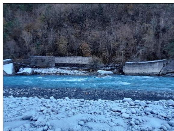
**Ancien ouvrage hydraulique effondré en rive droite, chenalisant l'écoulement**
