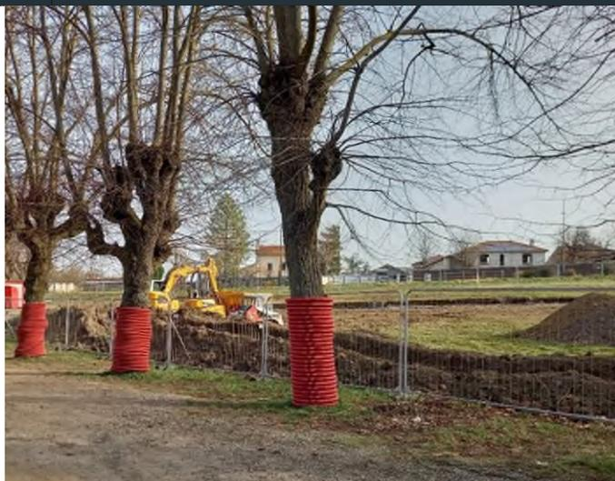
Figure 64 : Exemple de clôture fixe et de protection physique du tronc à mettre en place, S. Chaudet © EODD, 2022
