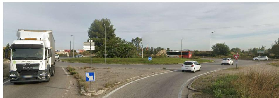
Le giratoire **B** est adjacent à A, à une centaine de mètres à l'Est de ce dernier. De taille compacte (rayon extérieur = 14 m), il bénéficie d'une voie directe de tourne-à-droite (ou shunt) Bellons-ouest → Bord de Crau-sud. Ce shunt est cependant largement sous-utilisé d'après les comptages directionnels (présentés dans un paragraphe ultérieur).
