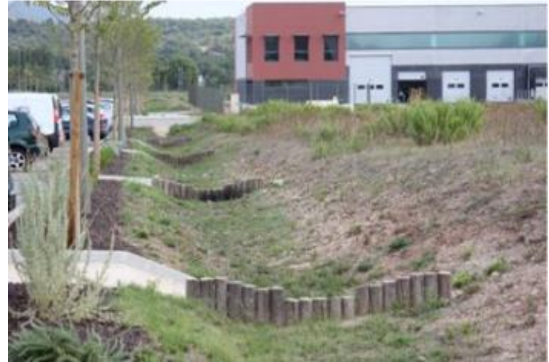
Zéro tuyau pour les eaux pluviales de la zone d'activité de camps de Sarlier
