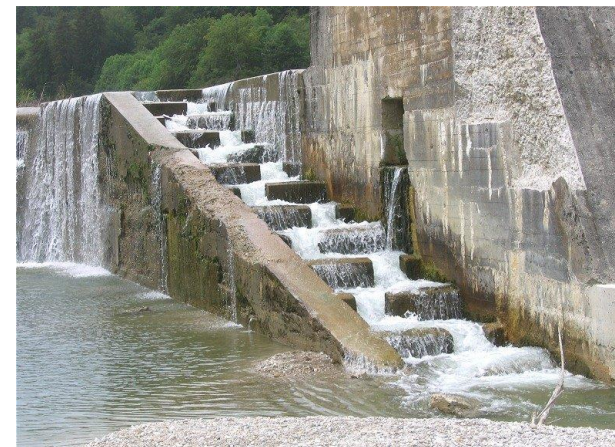
↑ infrastructures en béton
