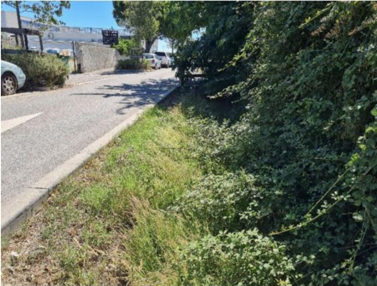
Remplacement de tuyaux par des noues infiltrantes sur le parc d'activités du Roubian à Tarrascon © Fleur CHAMBONNEAU (ARBE)
