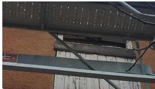
Toiture reprise et fenêtre Nord utilisée par les chauves-souris pour sortir
