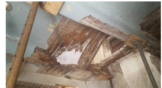
Chiroptière (fenêtre sud) pendant les travaux, réalisés en février en l'absence de la colonie
