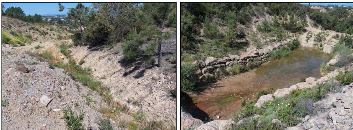
Fossé d'écoulement des eaux de pluie (à gauche), bassin de rétention (à droite)
