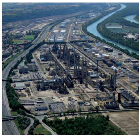
Vue d'ensemble du site de la plateforme de la raffinerie de Feyzin (Rhône) © Total
